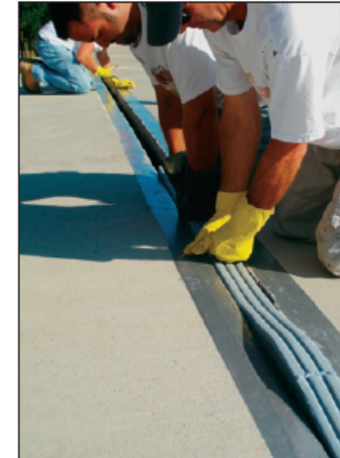
실리콘 밴드를 마지막으로 붙이기 전에 신축이음재와 밀봉재를 연결 부위의 틈새에 끼워 넣기만 하면 됩니다.
